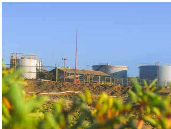
Donde el petróleo se acumula. En los tanques de la Batería Primavera se almacena el crudo que se extrae de los pozos más cercanos para luego ser transportado a la refinería de Talara. © Archivo Coast 2 Coast Movement (2017)
